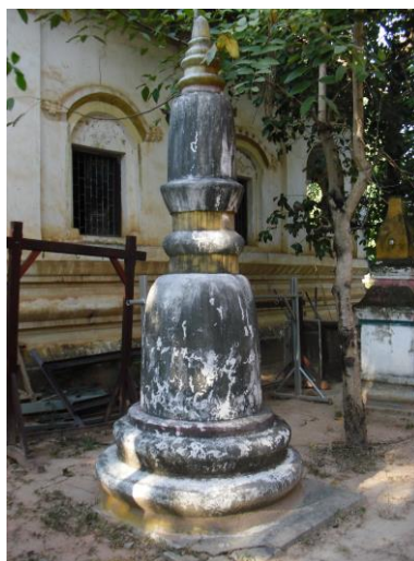
ภาพประกอบที่ 1 ธาตุอัฐิ อัญญา ครู ธรรม อดีตเจ้าอาวาสวัดบ้านภู
